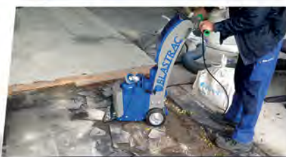
ОБДИРОЧНЫЕ МАШИНЫ ДЛЯ УДАЛЕНИЯ СТАРЫХ ПОЛОВЫХ ПОКРЫТИЙ
